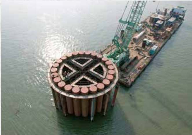
鋼管矢板打施工
