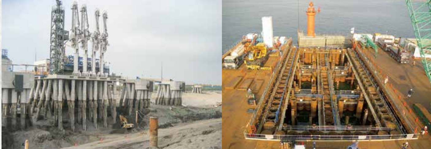
油圧バイプロハンマ打設最終油圧ハンマ打撃工法
