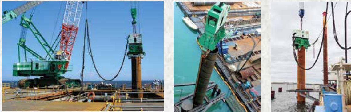
油圧バイブロハンマによる施工例
