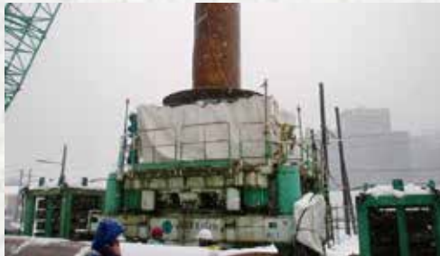
雪の中での溶接作業
