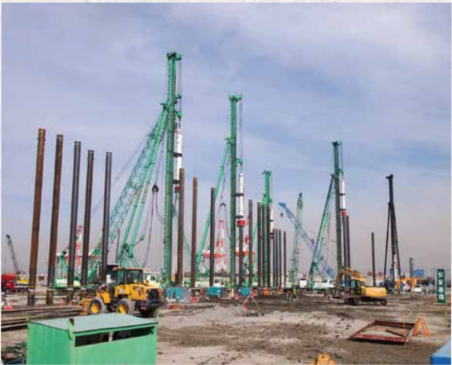
油圧ハンマ打設工法
