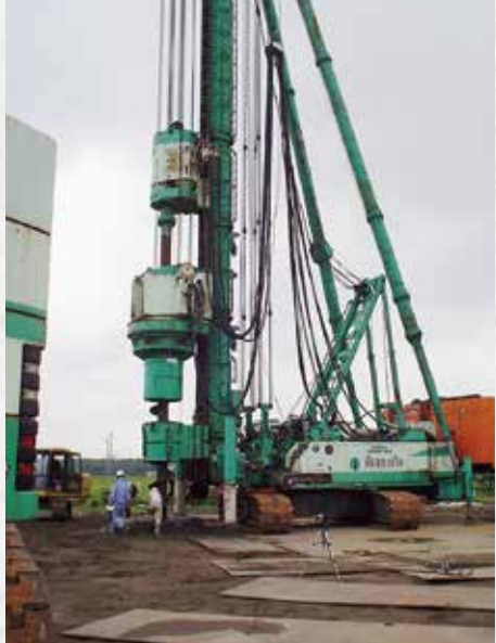
ドーナツオーガ工法
