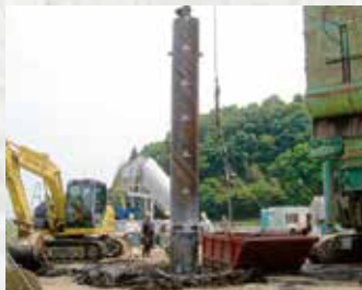
スパイラルオーガの接続
