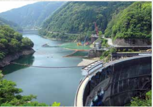
岩盤削孔鋼管矢板工法 (ダム再開発)
