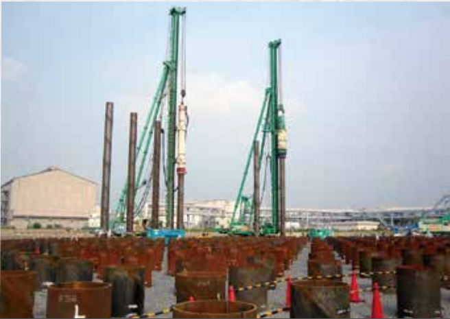
鋼管杭打施工
