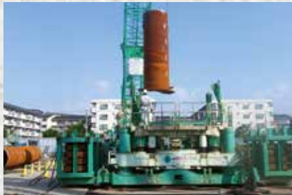
全周回転機による回転圧入
