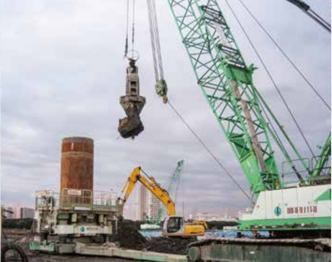
スーパートップ工法 (障害撤去)
