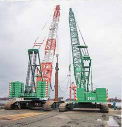
ウォータージェット併用 油圧バイプロハンマ打設工法
