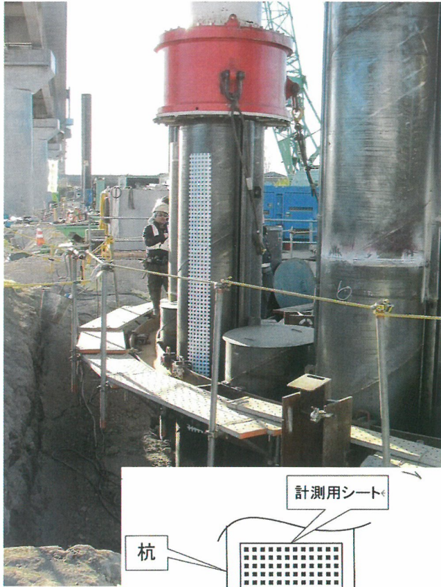
計測用シートを貼った打設杭
